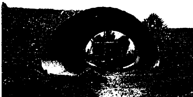
Рис. 21. Временные распорки для сохранения формы трубы при засыпке армогрунтовой (грунтовой) обоймы
